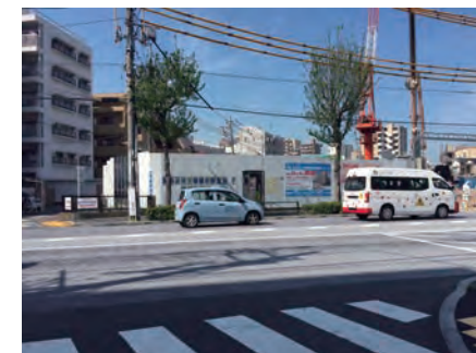
平成27年5月現在の建設地
